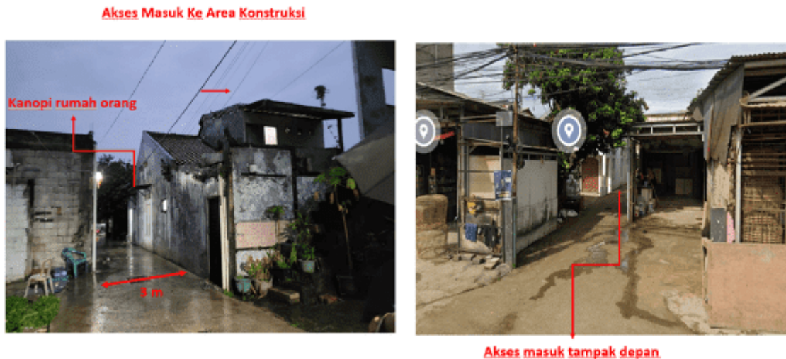
Gambar 4. Tinjauan Akses dan Sekitar Lokasi Pembangunan Rumah
