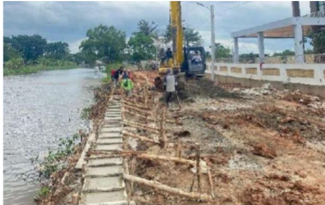
Gambar 2. Pekerjaan Bekisting
