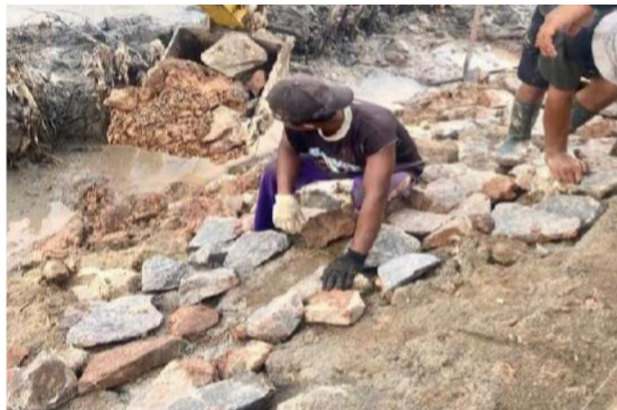
Gambar 3. Pekerjaan Pasangan Batu Kali
