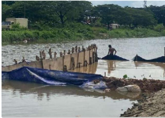
Gambar 4. Pekerjaan Pemasangan Kisdam
