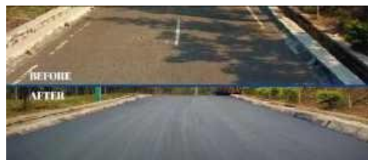
Gambar 13. Permukaan Jalan sebelum dan Sesudah Uji Penghamparan
