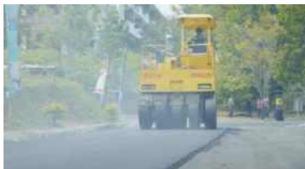
Gambar 9. Pemadatan dengan Pneumatic Tire Roller
