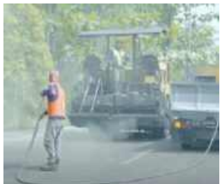
Gambar 4. Pembersihan Permukaan Jalan
