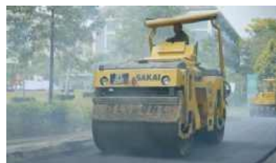
Gambar 8. Pemadatan dengan Tandem Roller
